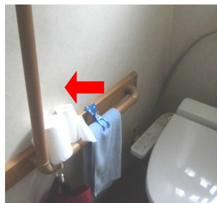
例①安全なトイレの立ち上がり、 L字型手すり を設置。
