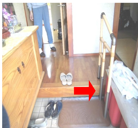
例②玄関の段差に、 据え置き型の手すり を設置。
